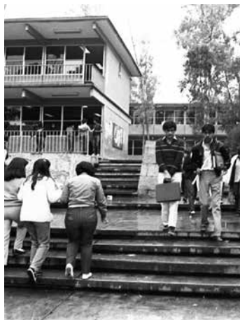
Costado del edificio "A".
